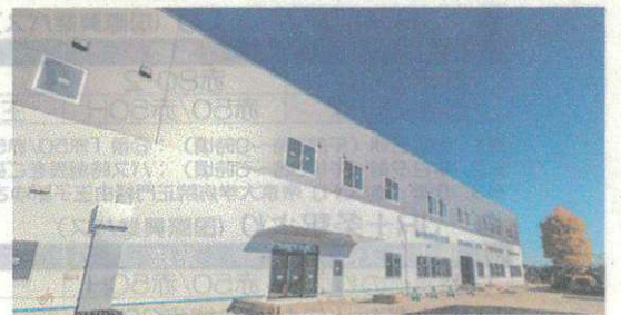
※新築校舎外観：令和8年竣工前 令和7年12月10日撮影
